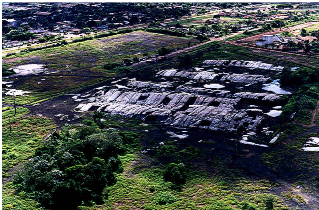
Fig. 3 – Depósito à superfície, no interior da Área Industrial, dos rejeitos retirados da bacia de rejeitos das usinas de pelotização e sinterização.
