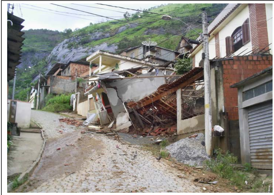
Foto 01 – Casas localizada na rua mais a montante do bairro Progresso atingidas no início do movimento de massa .
