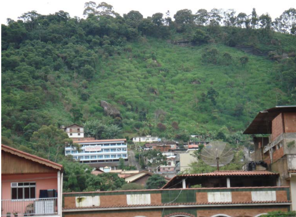
Foto 01 – Vista geral da encosta a montante do Jardim Ouro Preto. Observar o bloco de rocha logo acima das construções, à esquerda da foto.
