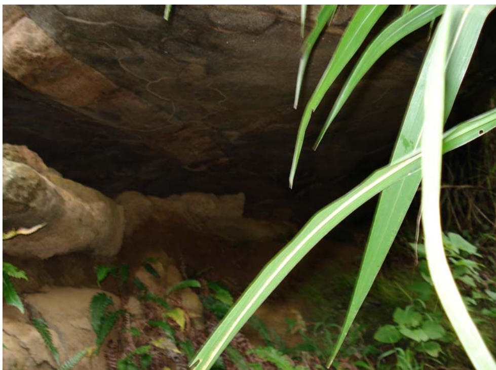
Foto 08 – Detalhe do vazio na base do bloco rochoso.
