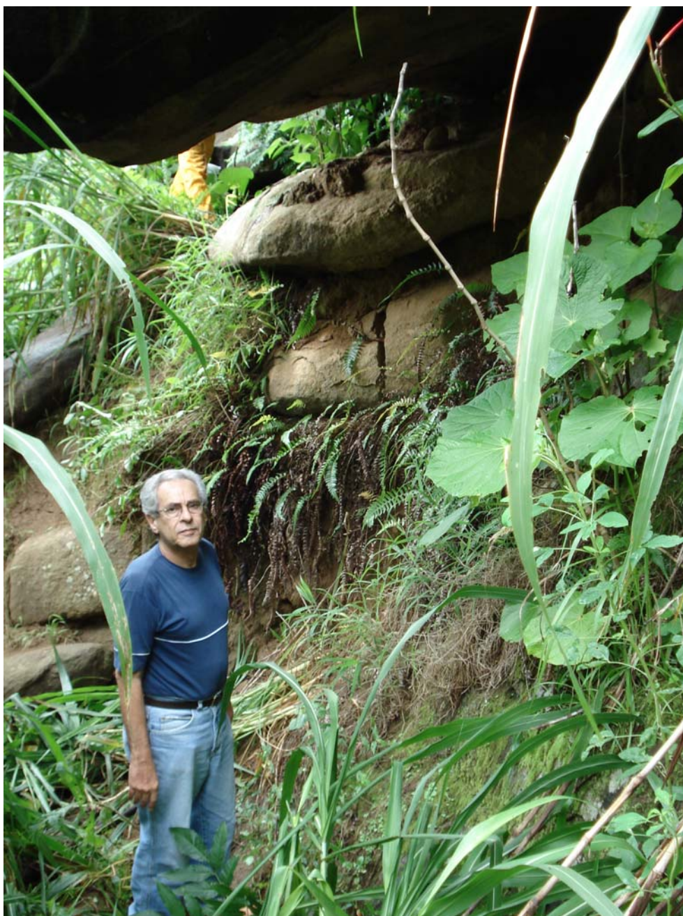
Foto 06 – Grande bloco rochoso em balanço com blocos menores soltos na base. Encosta a montante da rua Santa Marta, Jardim Ouro Preto.
