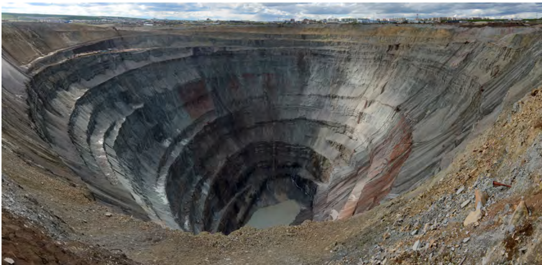
Figura 111 – Método de lavra a céu aberto em bancadas (mina Mir; Sibéria, Rússia).
