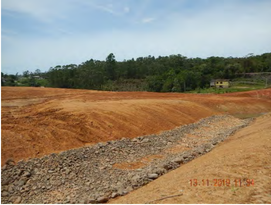
Obra de drenagem das águas pluviais e cobertura de argila implantada sobre os estêreis de cobertura.
