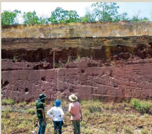
● Equipe da CPRM/SGB analisando focos de erosão em corte de talude em afloramento de rocha sedimentar, para elaboração do levantamento da geodiversidade do estado do Tocantins.
