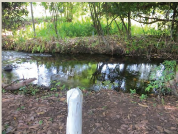
● Estação fluviométrica Canabravão, instalada no rio do Nado (Barreiras, BA).
