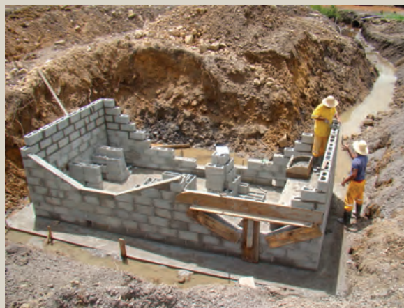
● Construção de caixa coletora de drenagens.
