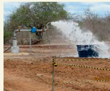
Teste de vazão no poço de Ibimirim (PE).
