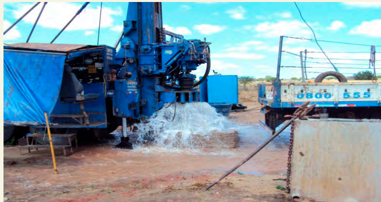
Desenvolvimento de poço em Serra Talhada (PE).
