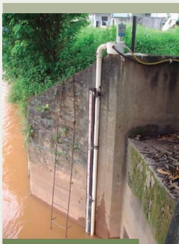
*Instalação do sensor de nível da estação automática de Ponte Nova – Bacia do rio Doce (ES).*
