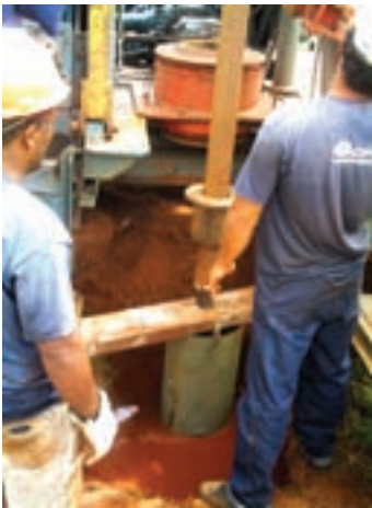
Sonda de perfuração de poços em operação.
