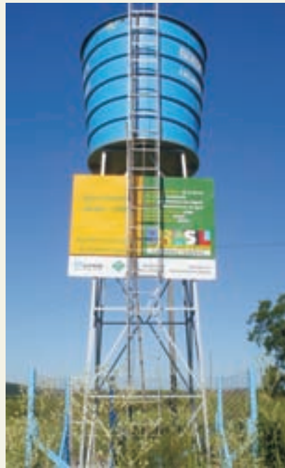
Poço no assentamento de São Miguel (Candiota – RS). Na sequência: poço antes da revitalização; limpeza do poço com produto químico e compressor; visão geral do abrigo do quadro de comando e do (SSA); vista do reservatório com capacidade para 15 mil litros de água e torre de 6 metros de altura.
