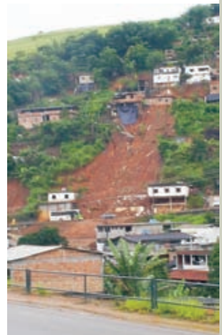
Área de ruptura de talude no bairro São José, em Cantagalo (RJ).
