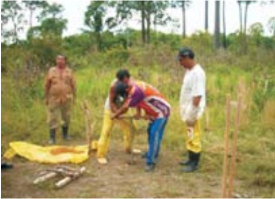
Perfuração a trado para avaliação de terreno com vistas à implantação do aterro sanitário de Parintins (AM).
