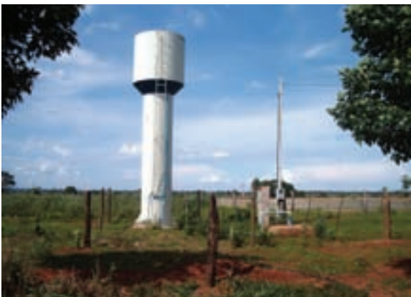
Sistema Simplificado de Abastecimento por Água Subterrânea (SSA), no assentamento de Nossa Senhora Aparecida (SP).
