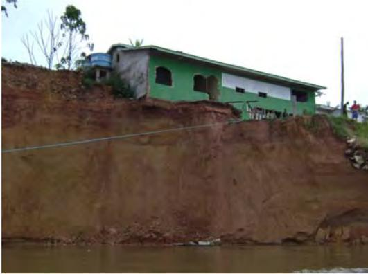
Construção em situação de risco devido a desmoronamento do talude do rio Solimões, na orla da cidade de Jutai (AM).
