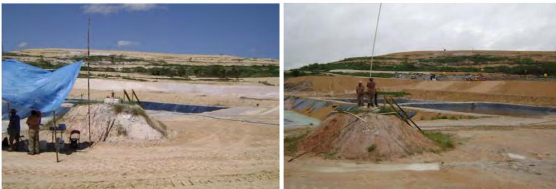
Vistas das lagoas de estabilização de chorume, instaladas a partir de 2008 na borda norte do aterro sanitário de Manaus, ao lado de poço de monitoramento perfurado para acompanhar a evolução da contaminação.
