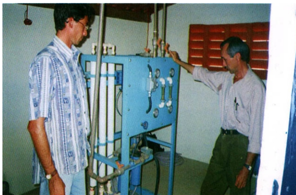
Dessalinizador de água subterrânea operado por energia solar, Livramento, município de Irauçuba, CE.
