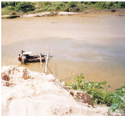
Draga em trabalho de extração de areia para construção civil, no leito do rio Vaza-Barris. Areal São Carlos (município de Itaporanga d'Ajuda – SE). Cadastrado pelo Projeto Minerais Industriais do Sul da Província Borborema.
