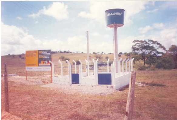
Revitalização e instalação de poço em Serra Vermelha, município de Ibimirim (PE).
