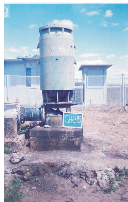
Poço no Vale do Gurguéia (PI). Cadastramento de poços em parte do semi-árido brasileiro.
