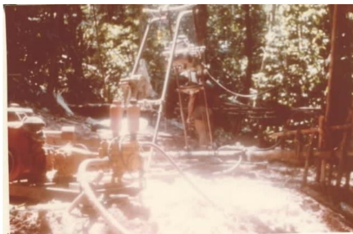
Figura 7 – Sonda Winkie GW-15 instalada e preparada para início de perfuração.
