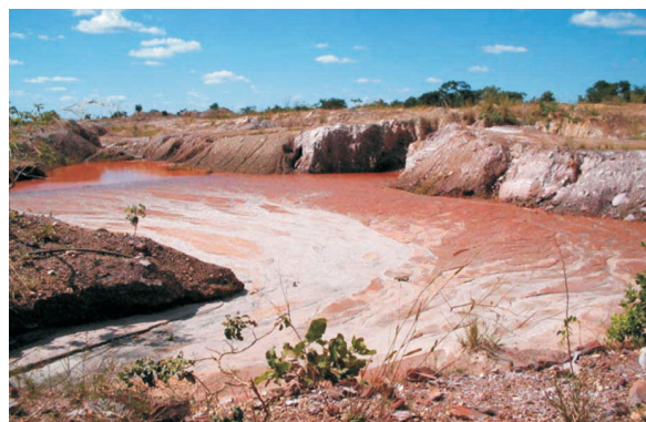
Vista geral da barragem de rejeitos para preenchimento de antigas cavas do garimpo de ouro na fazenda Santa Edwiges, às margens da BR-070, município de Nossa Senhora do Livramento (MT).
