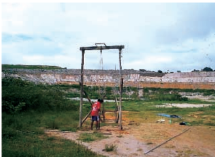
Abertura de poço para monitoramento da qualidade das águas subterrâneas no entorno do Aterro Sanitário de Manaus.
