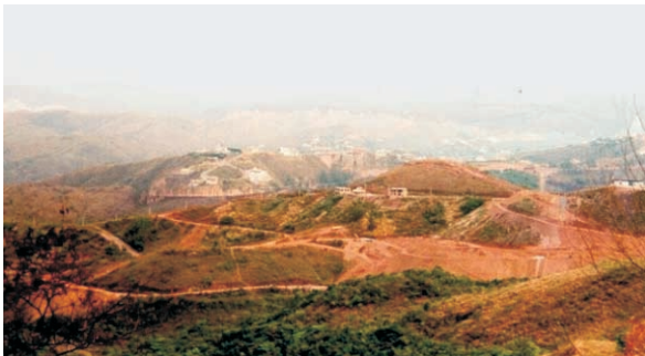
Espigões da vertente sul da serra do Curral sofrendo processo de ocupação recente. Construção de casas de alto padrão em área de risco geológico.
