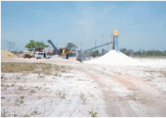
Planta de beneficiamento de calcário magnesiano, na borda da Chapada das Mangabeiras, no estado do Piauí (PI).
