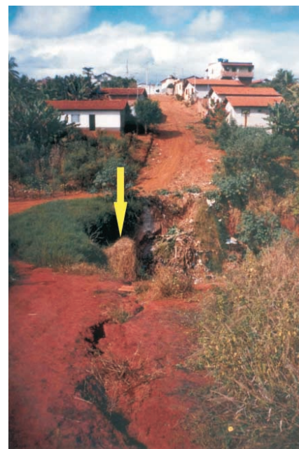
Vista da cabeceira de erosão interceptando o cruzamento de duas ruas, em Virgem da Lapa (MG). Em primeiro plano, observa-se a regueira que conduz as águas da rua para o interior da ravina. A seta indica uma porção do terreno que está prestes a desmoronar.
