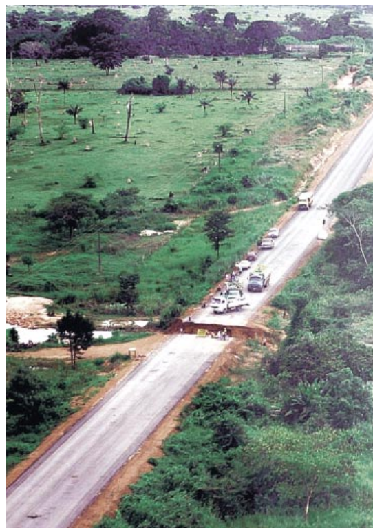
Trecho da BR-163, área do Projeto Zoneamento Ecológico-Econômico, que visa a implementar conceitos de sustentabilidade em apoio às decisões dos responsáveis pela gestão do território.
