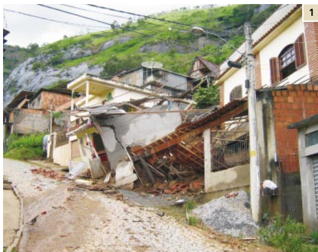
1 – Escorregamento generalizado, afetando várias comunidades na cidade de Nova Friburgo (RJ).
