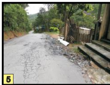
Muitas trincas no asfalto, causadas pela água. Ausência de canalizações para escoamento da água pluvial.
