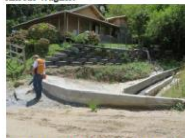
Figura 39. Situação atual de obra de drenagem de linha de água sob a SC-350, km 432,5.
