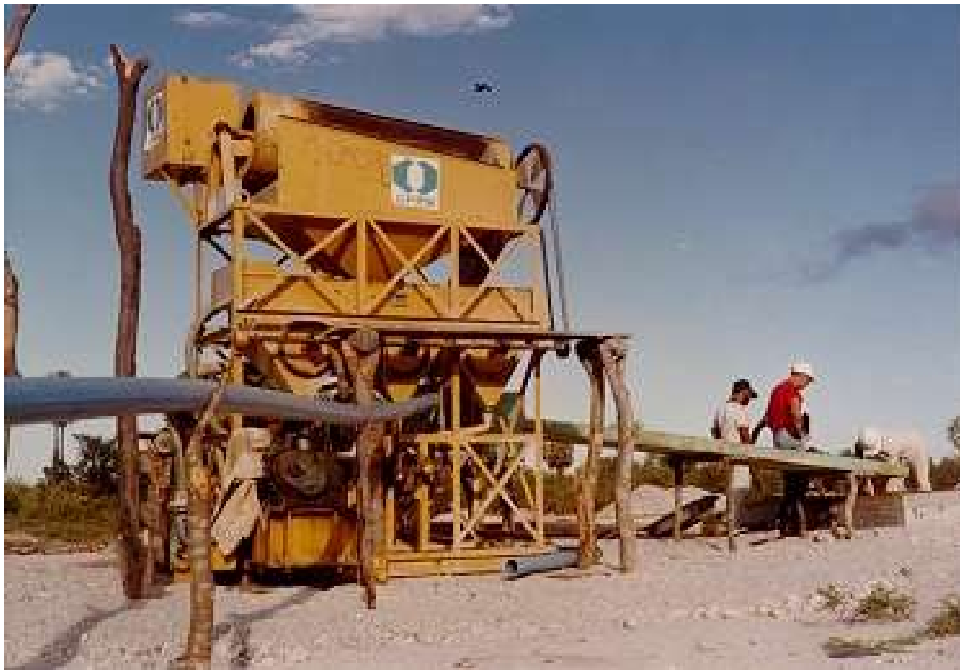
Vista geral da planta de beneficiamento de minério Ourotec M-10.
