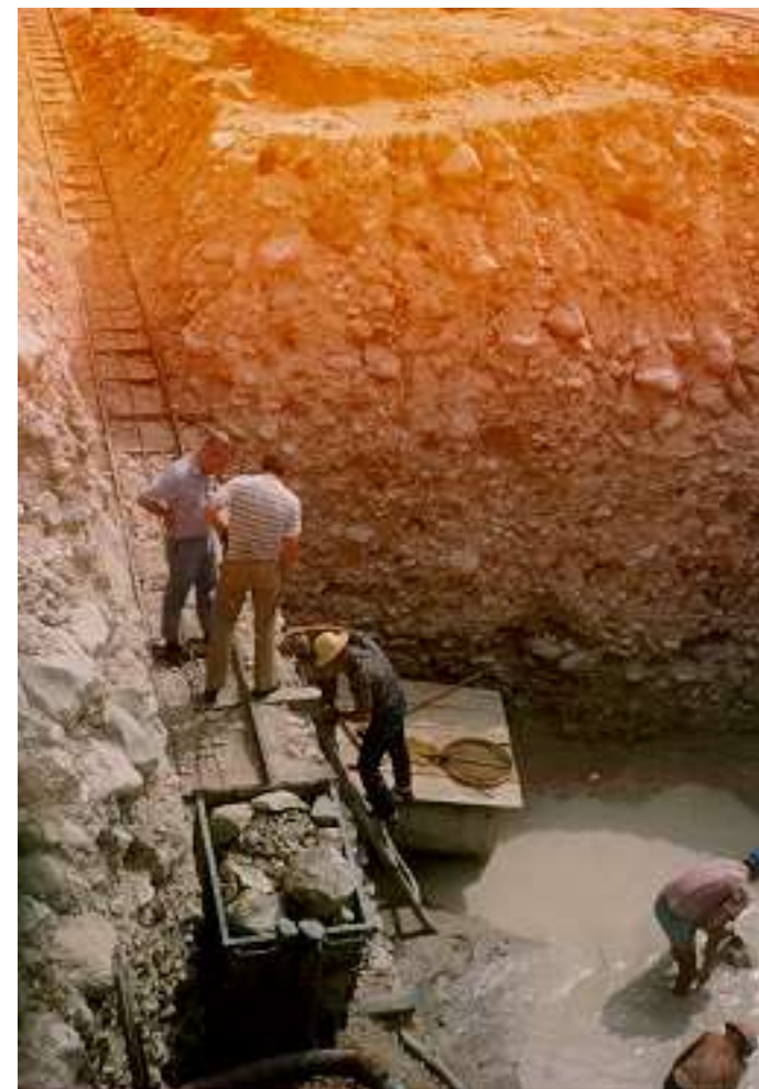
Mini vagão para remoção de blocos de cascalho maiores.
