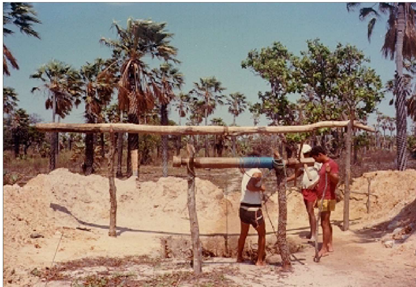
Abertura de poço exploratório.
