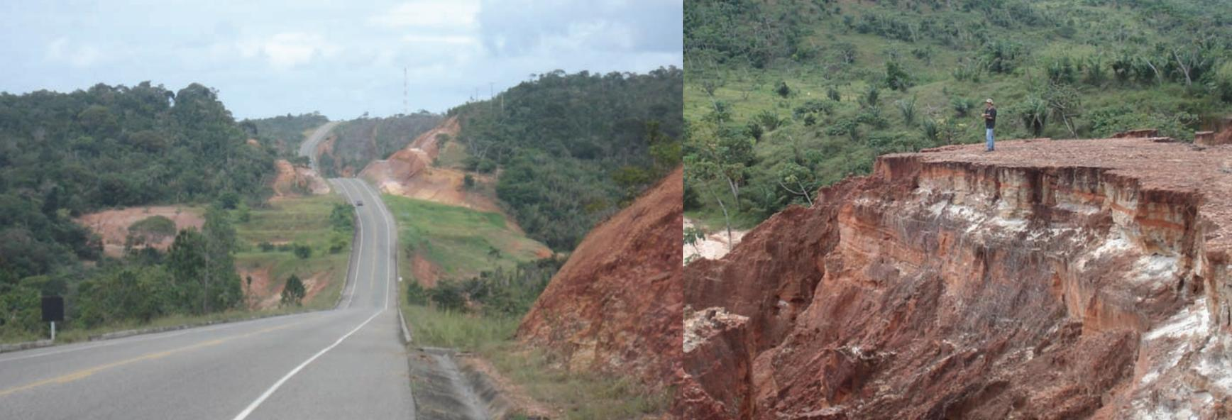
O Mapa Geodiversidade do Estado da Bahia destaca áreas do Grupo Barreiras, ao longo da Linha Verde, com alta suscetibilidade a processos erosivos, em função dos cortes na estrada e obras de drenagem mal dimensionadas.
