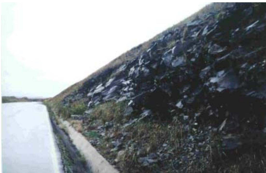
**Figura 6** - Intensa disjunção horizontal com mergulho comum nas rochas vulcânicas ácidas do Tipo Palmas. BR-280 na proximidade de Palmas-PR.
