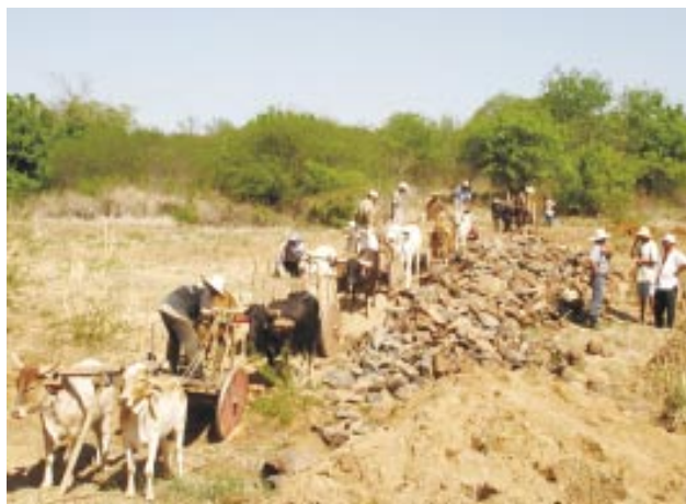
Construção da barragem subterrânea de Conceição de Cima, Serra Talhada (PE).
