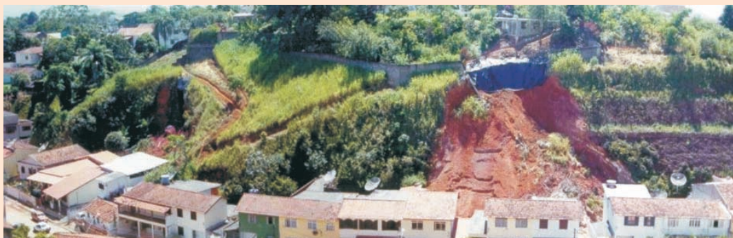
Vista do talude de alta declividade com ruptura em dois pontos da vertente, colocando em risco as moradias da rua General Prattis de Aguiar, no bairro Tangará, Resende, RJ. Área do projeto Prevenção de Calamidades por Intempéries.
