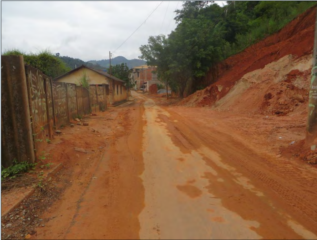
Material erodido dos cortes acumulados nas vias, Antônio Dias – MG. Créditos: Rafael Araújo, CPRM/SBG
