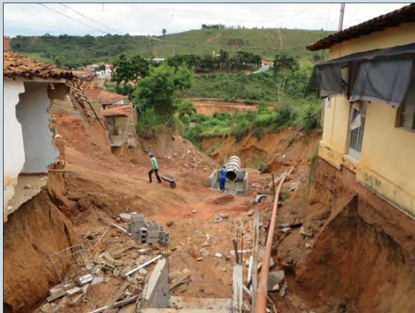
Erosão causada por sobrecarga do sistema de drenagem pluvial. Capelinha – MG. Créditos: Júlio Lana, CPRM/SBG
