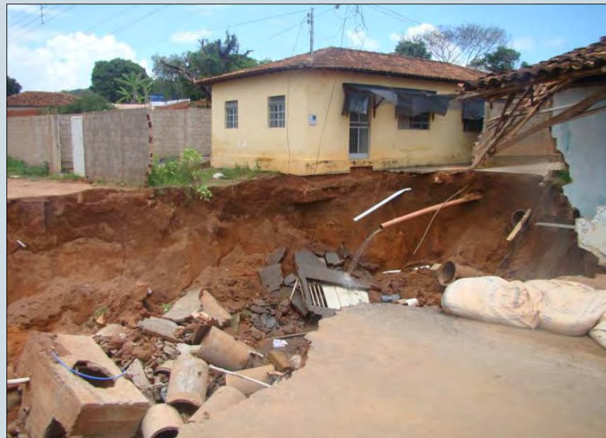
Erosão causada por sobrecarga do sistema de drenagem pluvial. Capelinha – MG. Créditos: Júlio Lana, CPRM/SBG
